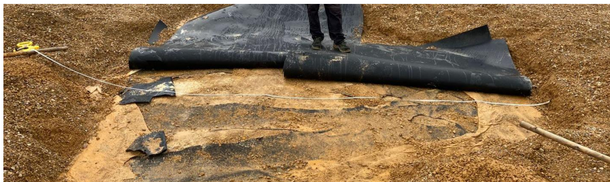
Рис. 5 Деформация 3 (примерный размер 350х60см)
